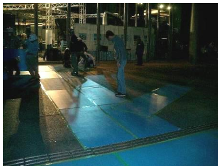
軽量物搬入ルート 養生方法 Pボード3mm
