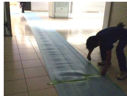
軽量物搬入ルート 養生方法 ブルーシート
