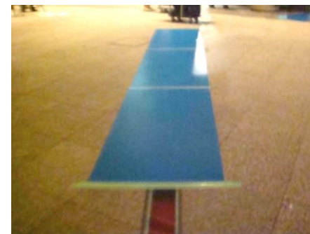
アートガラス 養生方法 Pボード3mm
