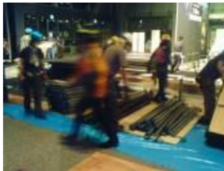
仮置き場 養生方法 (ビニールシート・コンパネ12mm)
